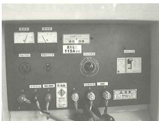
(写真4) 結線が終了した状態
