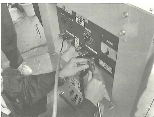
(写真3) 単相および三相電源の結線作業
